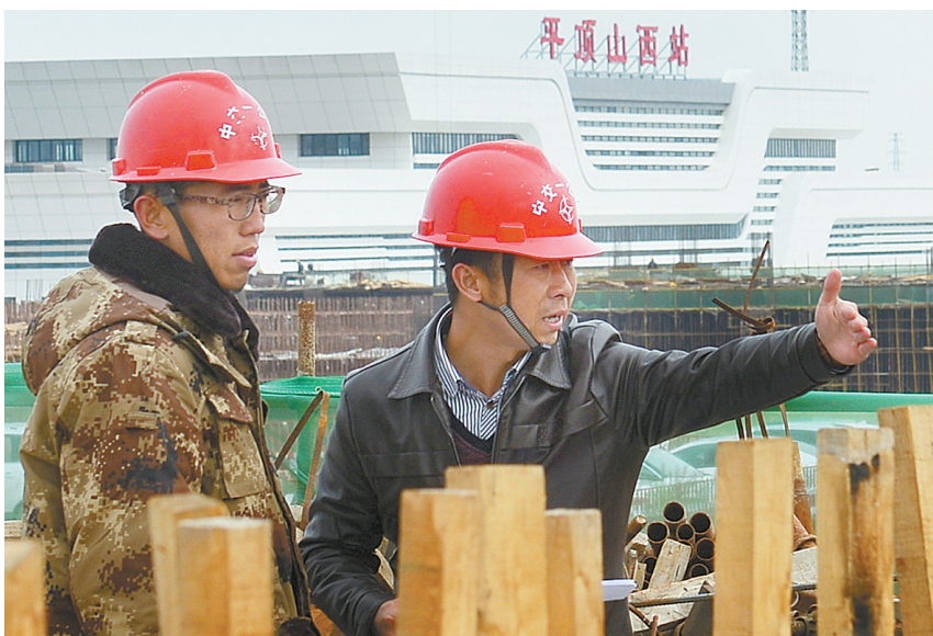
在跨郑渝高铁立交桥的工地上，杨赞(右)正在布置工作。
