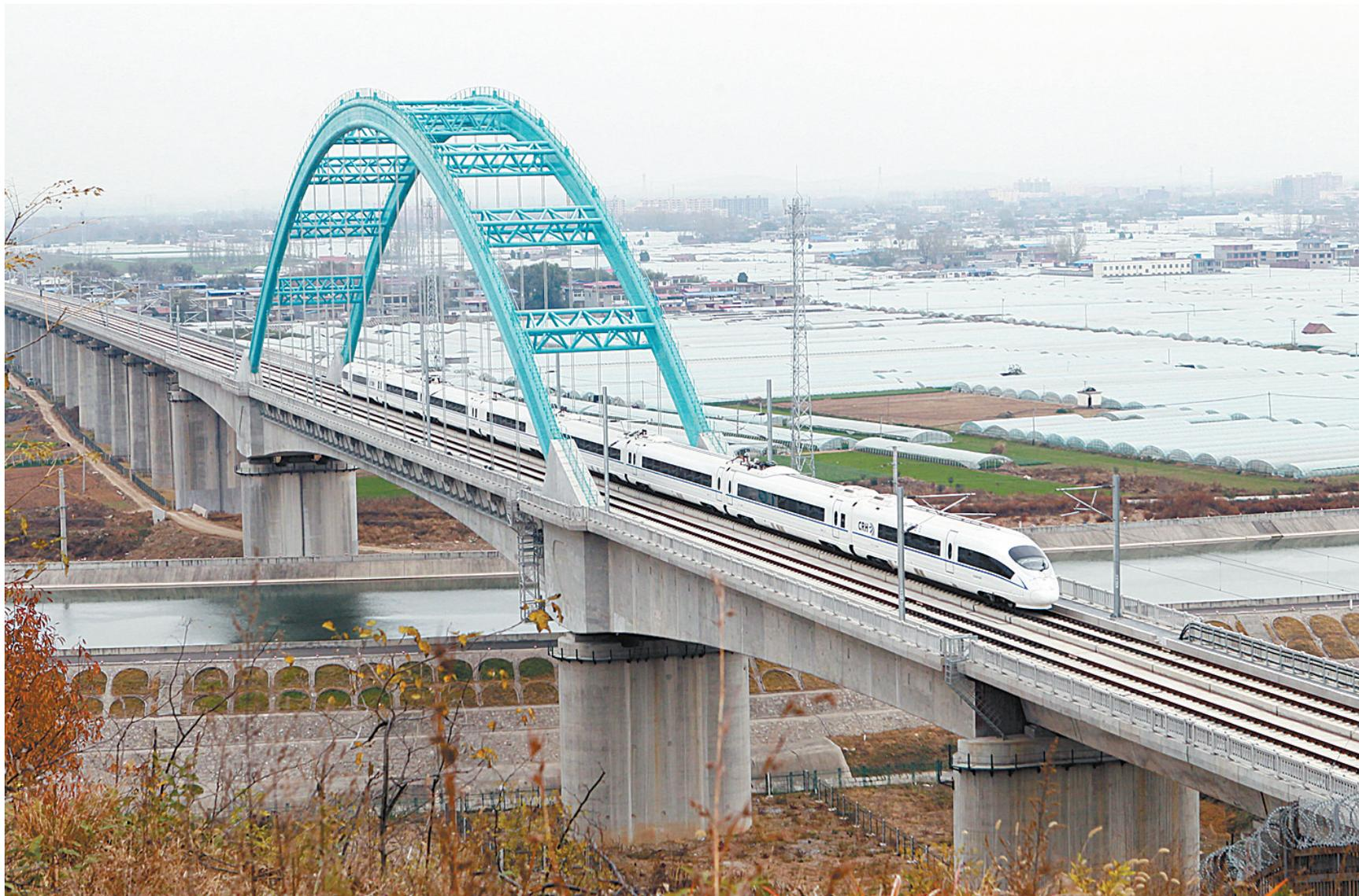
11月26日,郑州东开往邓州东的G55501次列车从位于鲁山县张良镇黄五常村西南侧的郑渝高铁南水北调中线输水干渠特大桥(郑渝高铁昭平台南干渠特大桥)上驶过。该桥跨度为160米,采用钢管拱形的造型设计,是我国首座高铁跨南水北调干渠特大桥。
