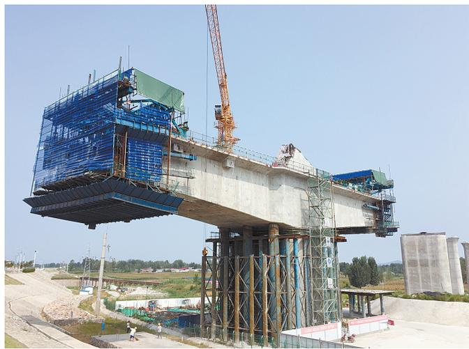
为了避免对周边水质和环境产生污染,施工人员采取了全封闭挂篮施工的环保作业方式。市铁路办提供
