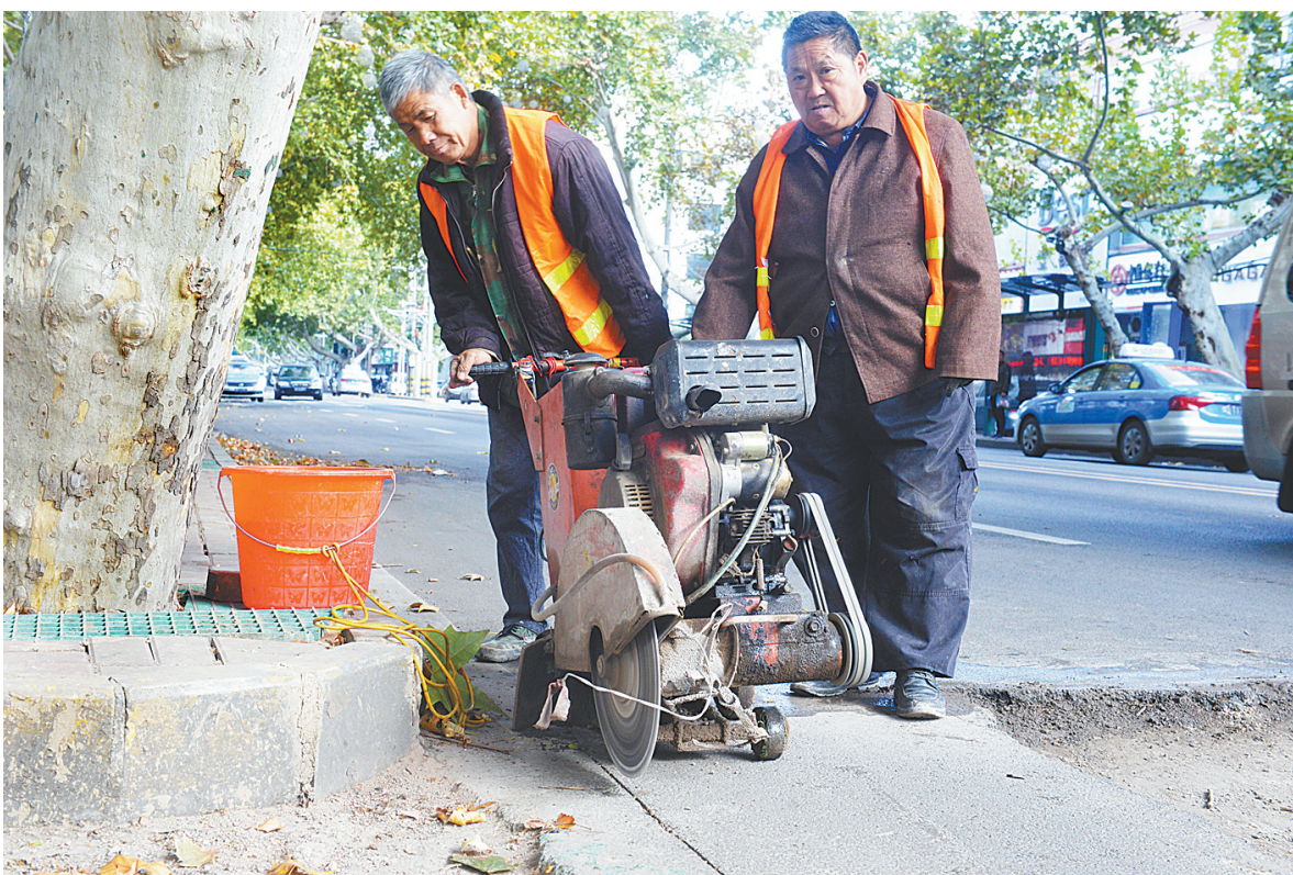
昨天,在市区光明路中段,施工人员用切割机切割机动车道和非机动车道接合处高出的路面。
