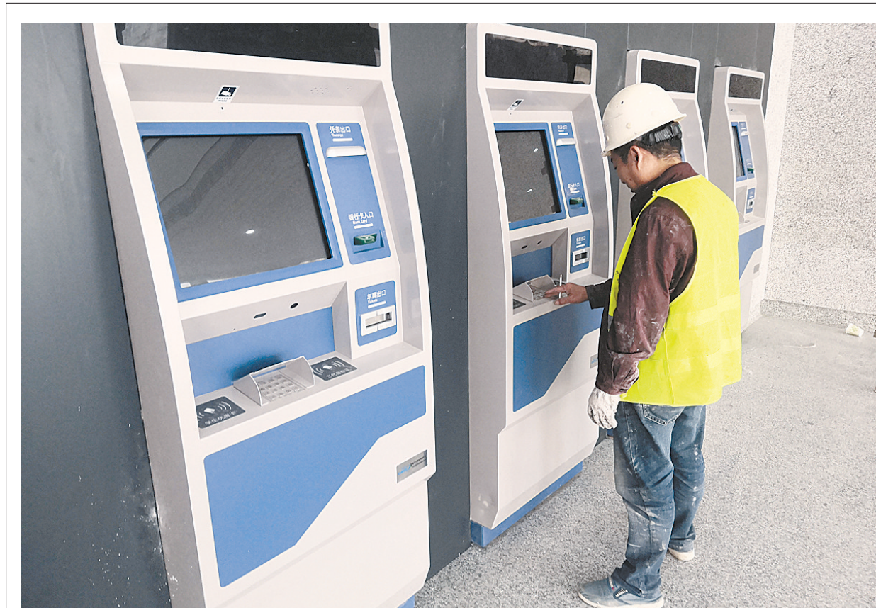
平顶山西站 正加紧建设
