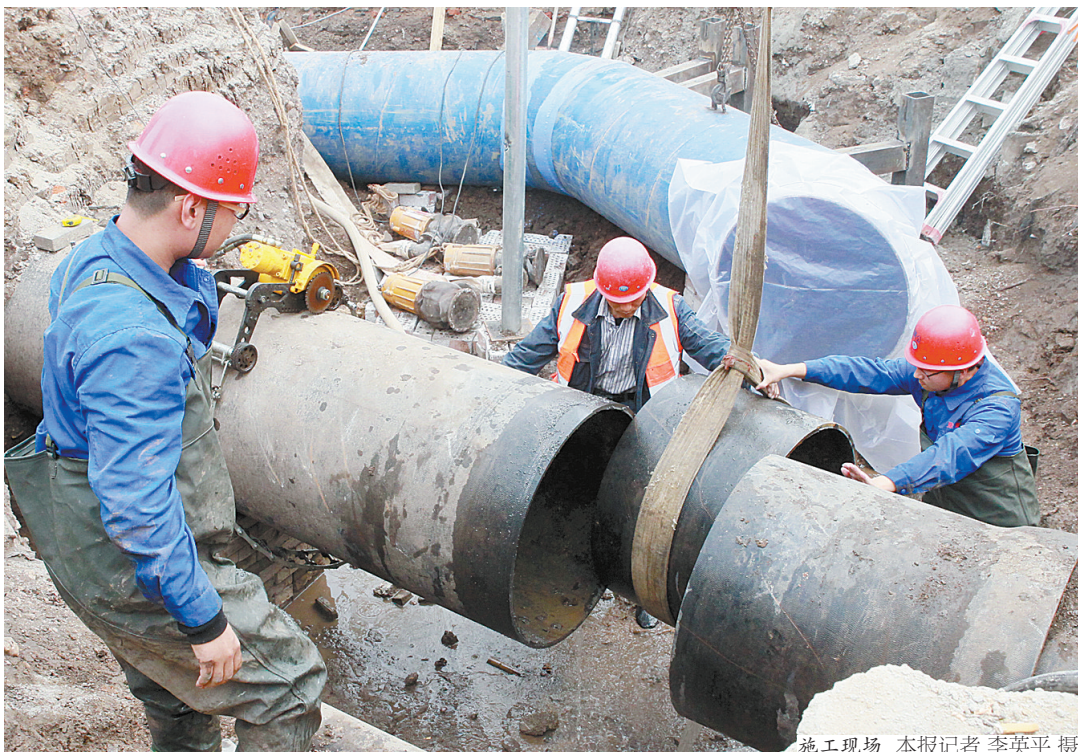
施工现场 本报记者 李英平 摄
