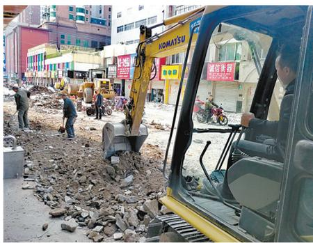
工程车辆正在拆除繁荣街原有路面。
