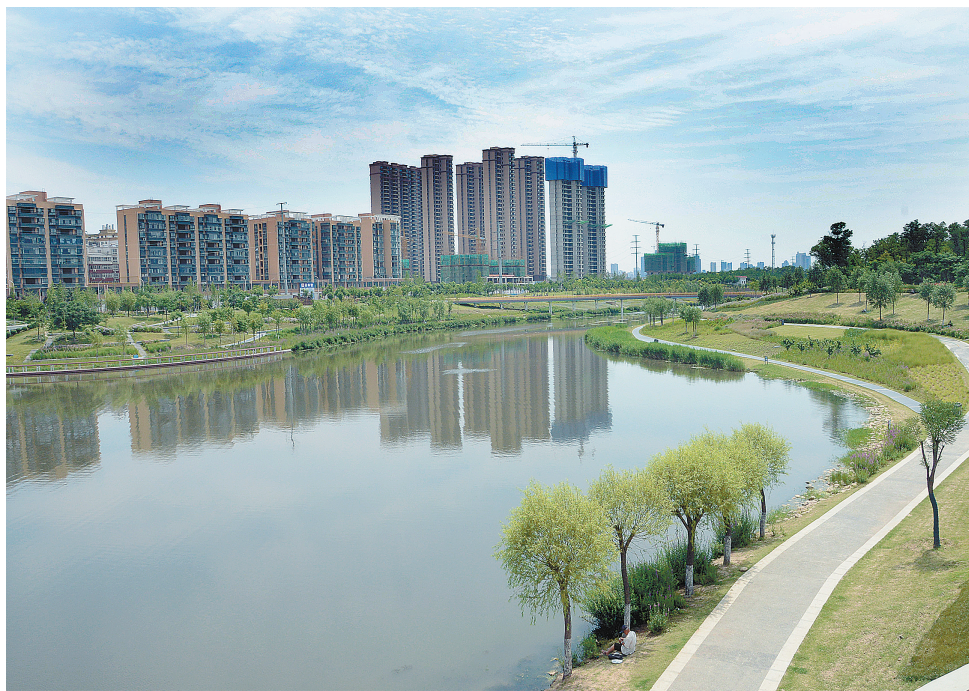
市区毗邻湛河的一处在建楼盘 本报记者 张鹏 摄
