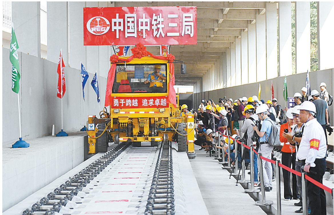
昨天,铺轨机在京张高铁清华园隧道进行铺轨作业。 新华社记者 张晨霖 摄
