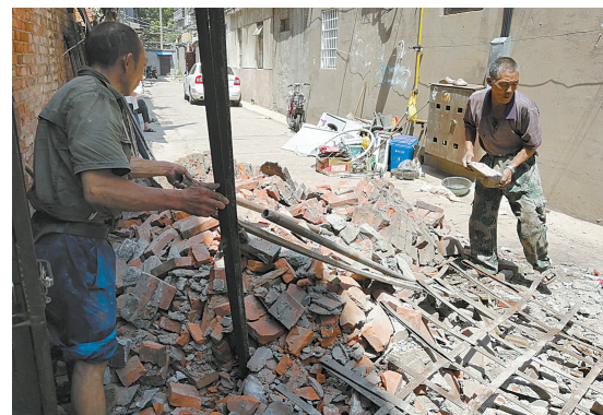
工作人员拆除违建房屋
