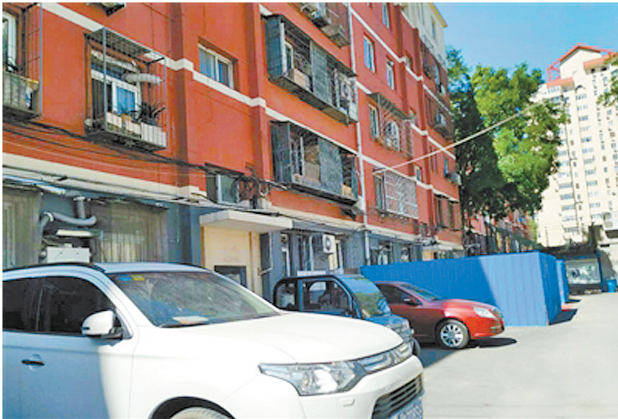
其他单元周围已开始施工安装电梯(蓝色围挡处),但涉事单元仍没有动静,部分业主心里十分着急。受访者供图
