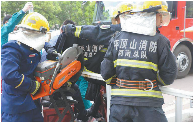
消防人员现场切割钢管
