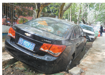
几辆轿车陷在西苑路开挖的土沟里。本报记者 彭程 摄
