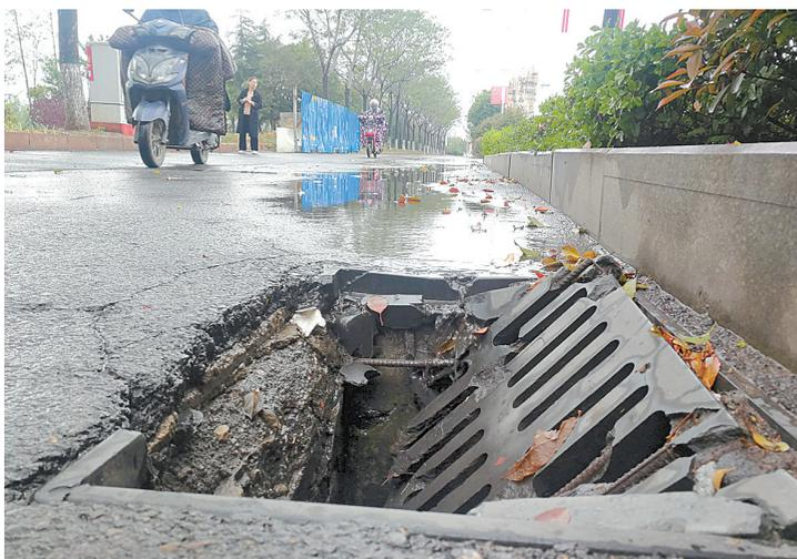
塌陷变形的雨水算子
