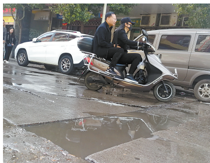
路面污水横流,行人通行不便。
