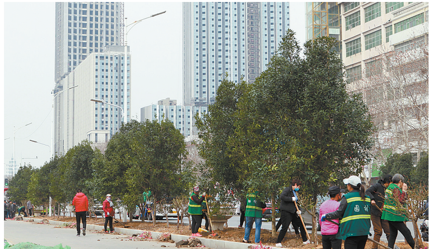
昨天上午,在中兴路与体育路之间的建设路上,绿化施工人员将桂树、高杆月季、石楠等观赏树木种在道路两侧的绿化隔离带中。本报记者 李英平 摄
