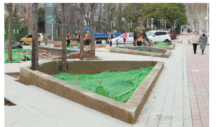
昨天,市区建设路与公园北街交叉口西南侧的街边小游园主体施工已经进入尾声,即将进入美化绿化阶段。本报记者 李英平 摄
