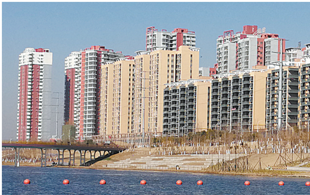
市区湛北路西段的新建居民楼 本报记者 张鹏 摄
