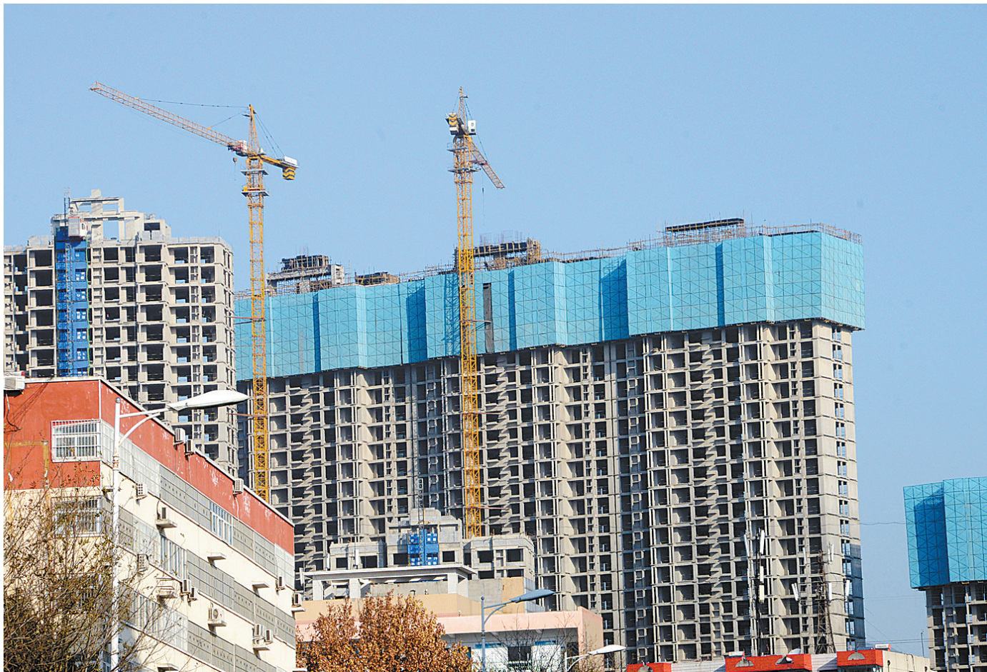
市区凌云路北段一在建框架式住宅楼 本报记者 张鹏 摄
