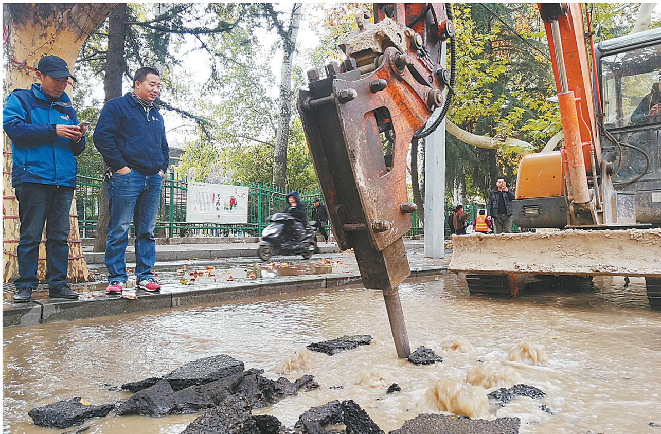
昨天上午,市自来水公司的职工操作工程机械破拆路面,维修爆裂的供水管道。 本报记者 彭程 摄
