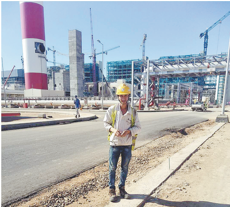
王艷偉在工地上
