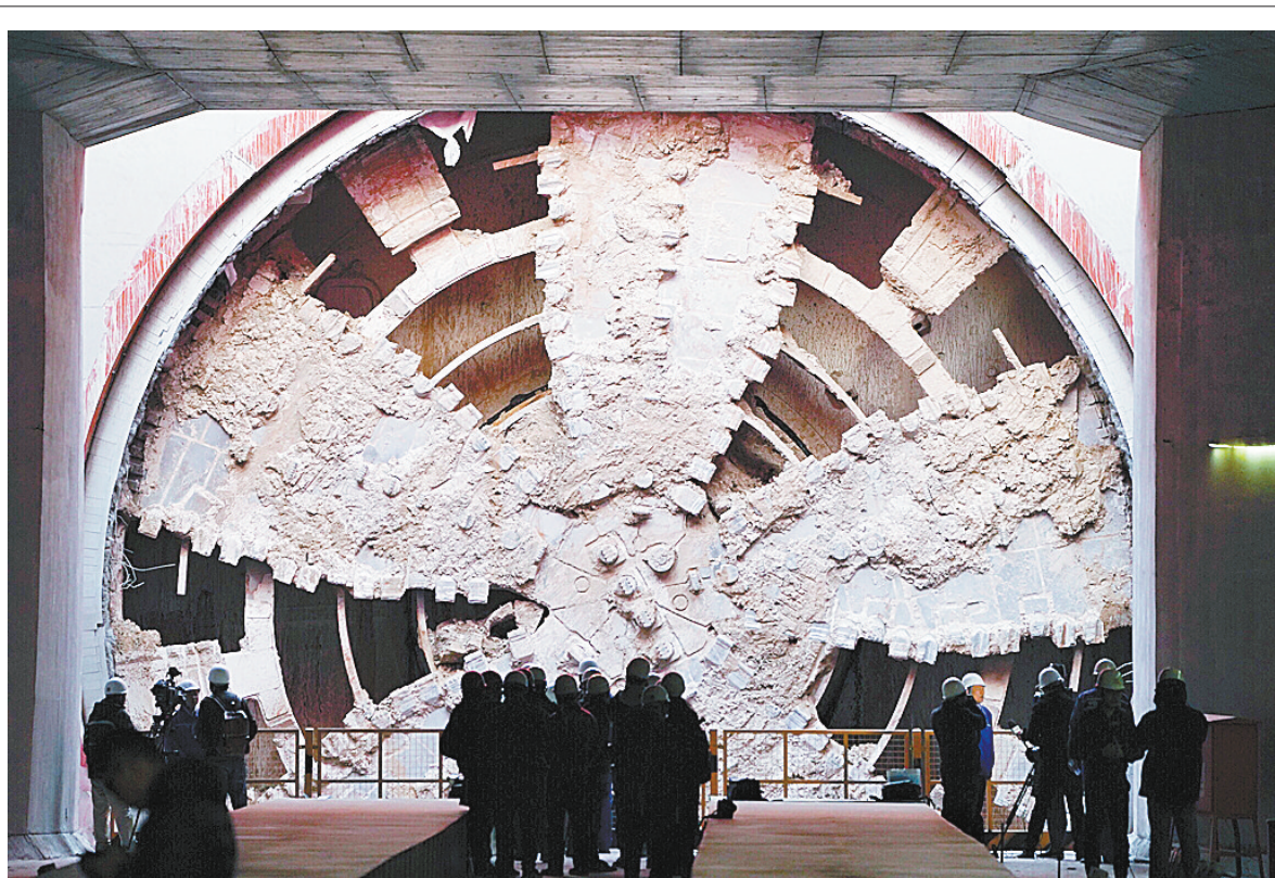
京张高铁清华园隧道贯通
