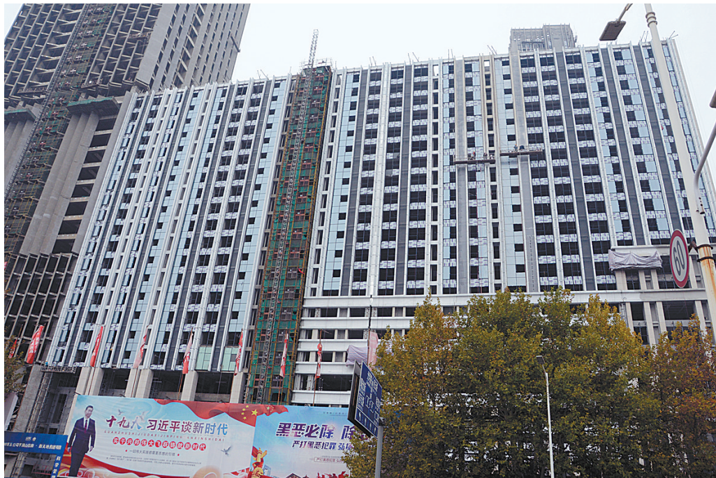
市区建设路中段一在建住宅楼
