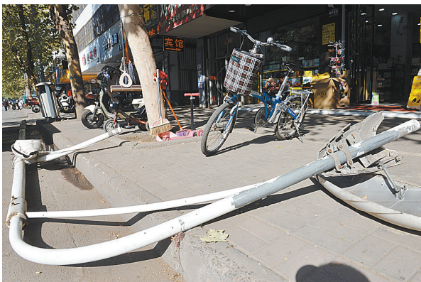
市区矿工路与东环路交叉口东侧,一根铁制灯杆倒在地上。
