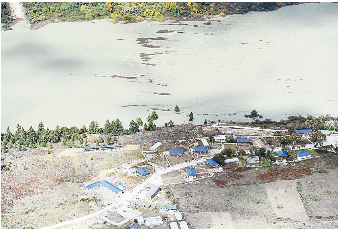
空中俯瞰加拉村(10月18日摄)新华社记者 普布扎西 摄
