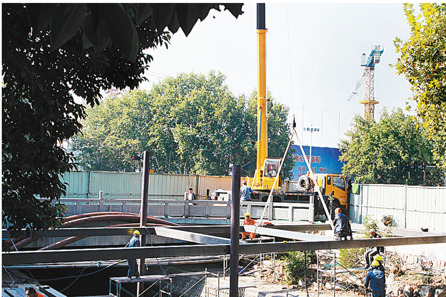
建设路西杨村河桥拓宽
