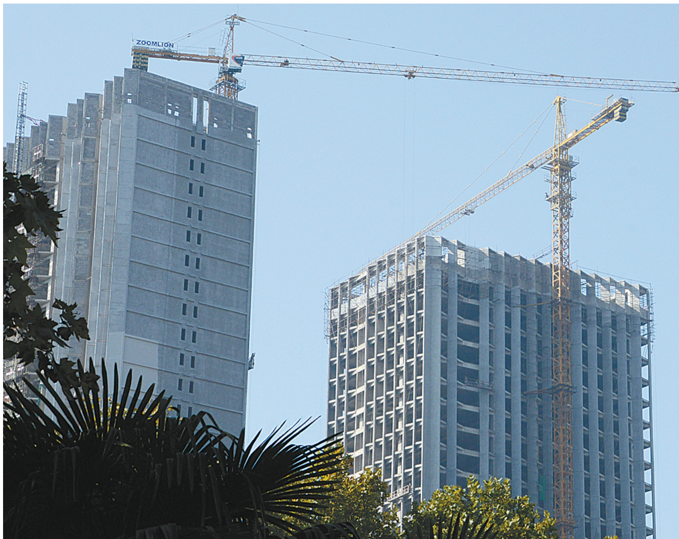
市区建设路一在建小户型公寓楼
