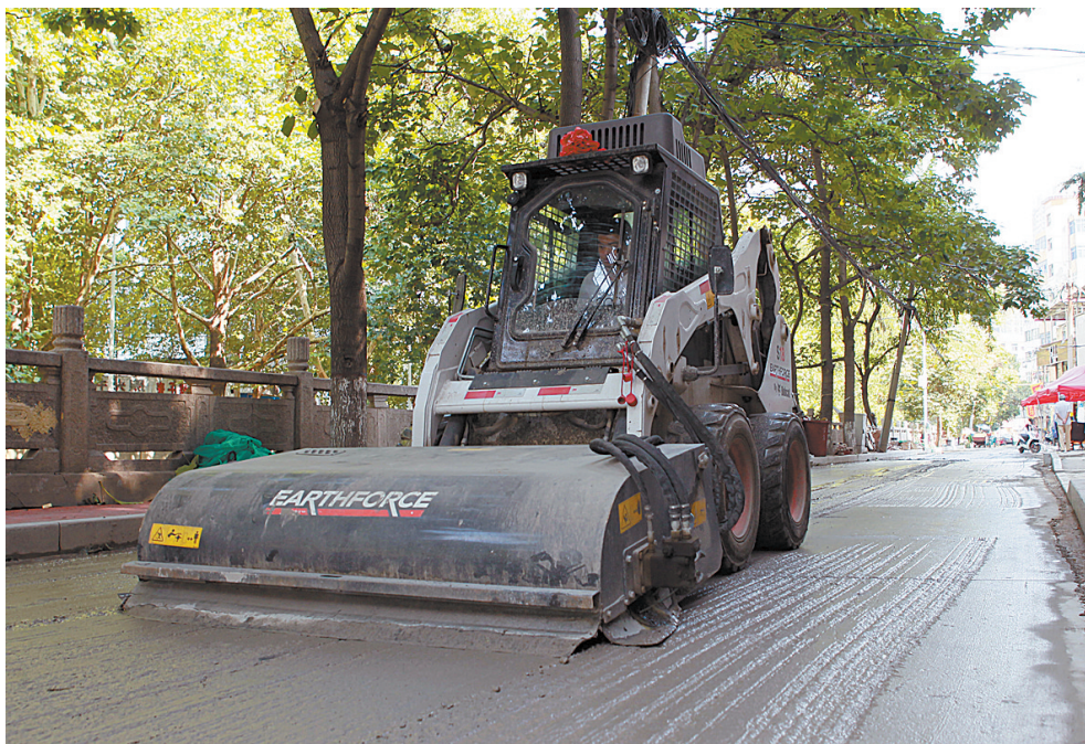
昨天上午,在市区朝阳路南段,大型施工机械在路面作业,为铺沥青做准备。本报记者 李英平 摄
