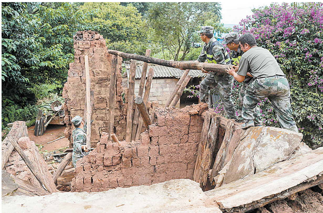
昨日,在墨江县通关镇牛库村,救援人员帮助村民清理受损的土墙,以防发生二次伤害。
