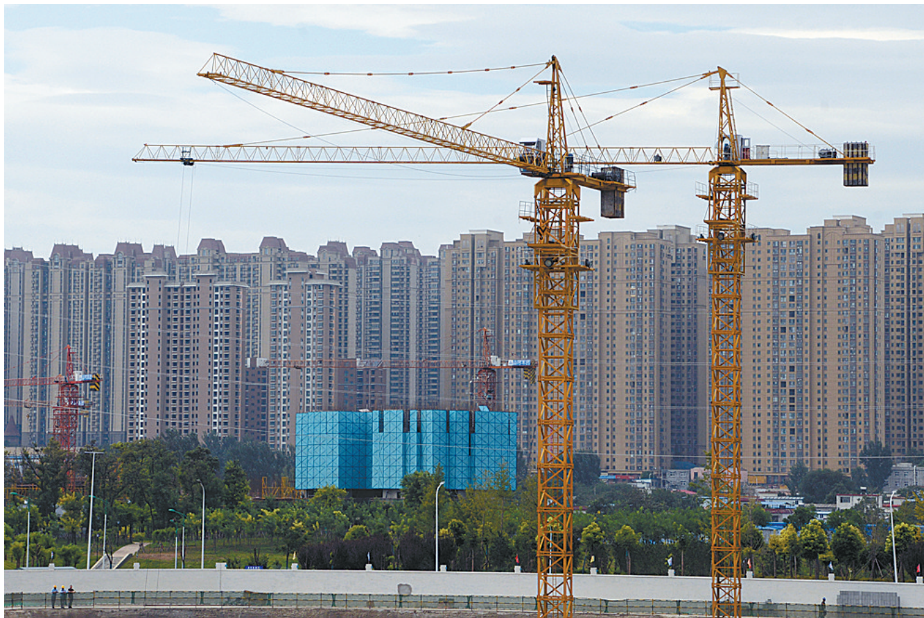
市区淇北路一在建住宅楼盘
