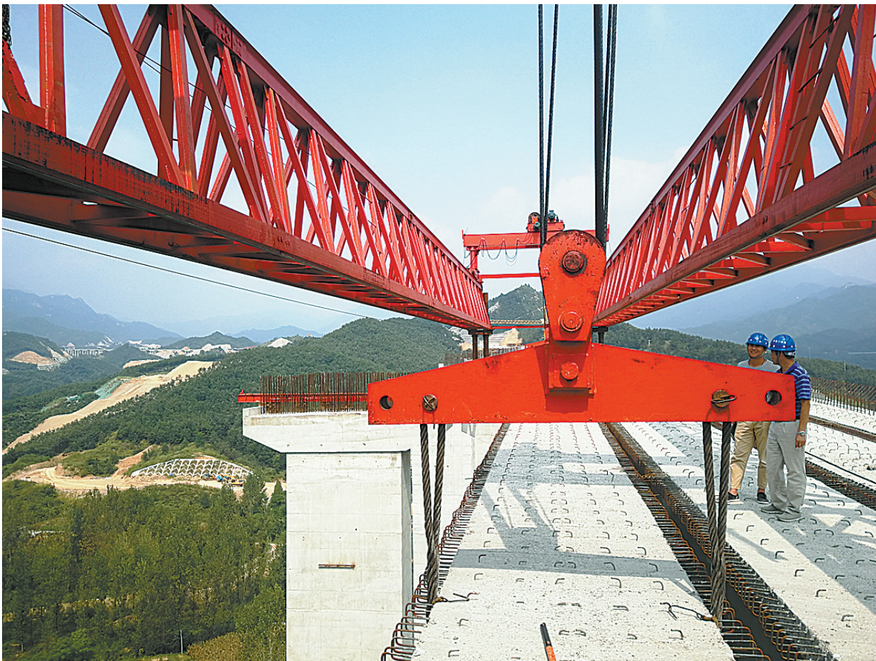
图为尧栾高速尧山段施工现场
