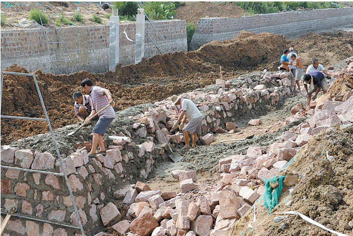
稻田沟河道升级整修
