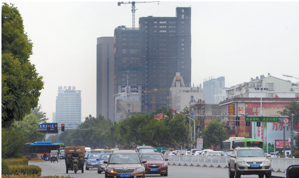
昨日,市区建设路一处在建楼盘远景。本报记者 张鹏 摄
