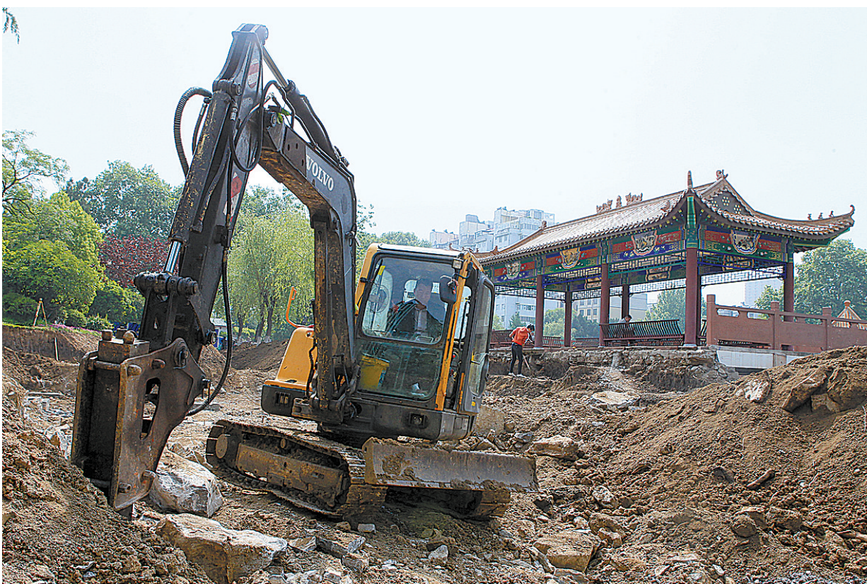
昨天上午,在市河滨公园人工湖北岸,一台挖掘机在开挖临湖步行栈道基坑。 本报记者 李英平 摄
