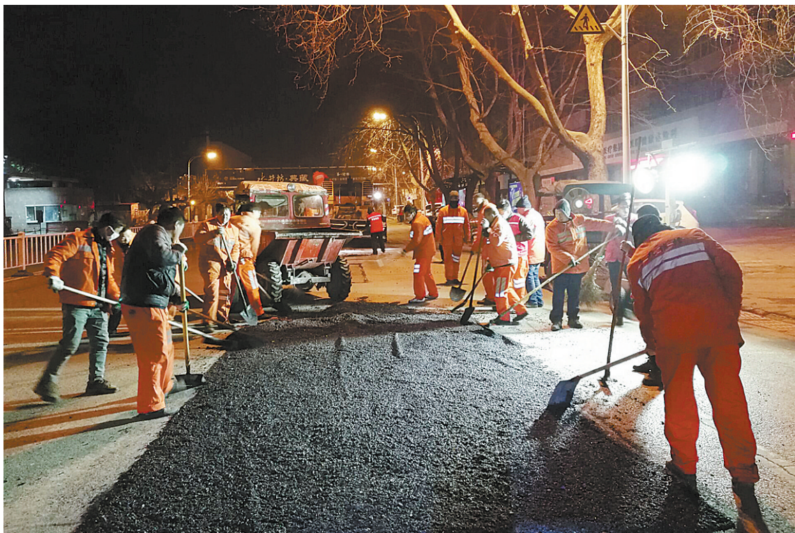
夜间修复破损路面
