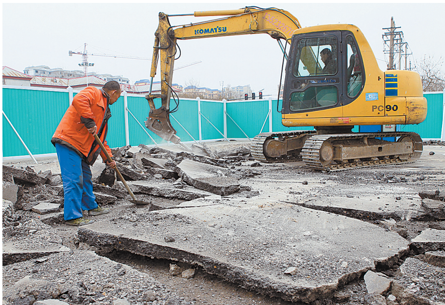
昨天,市区建设路与凌云路交叉口,施工机械在破除路面。本报记者 李英平 摄
