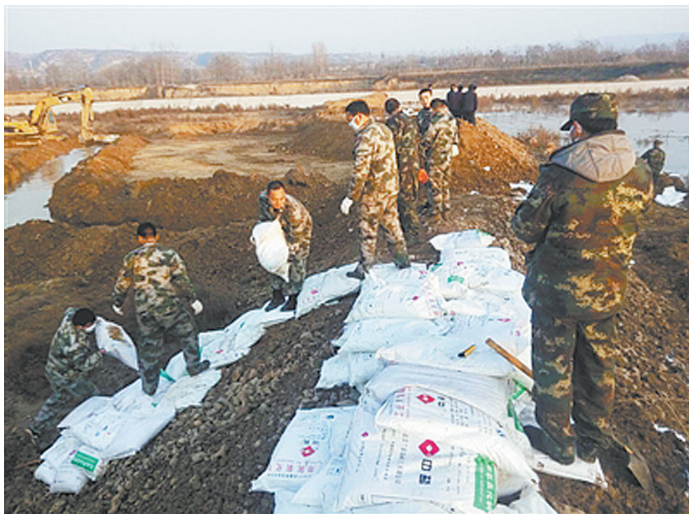
灵宝硫酸泄漏应急救援现场,工作人员搬运碱性物质进行中和处理。
