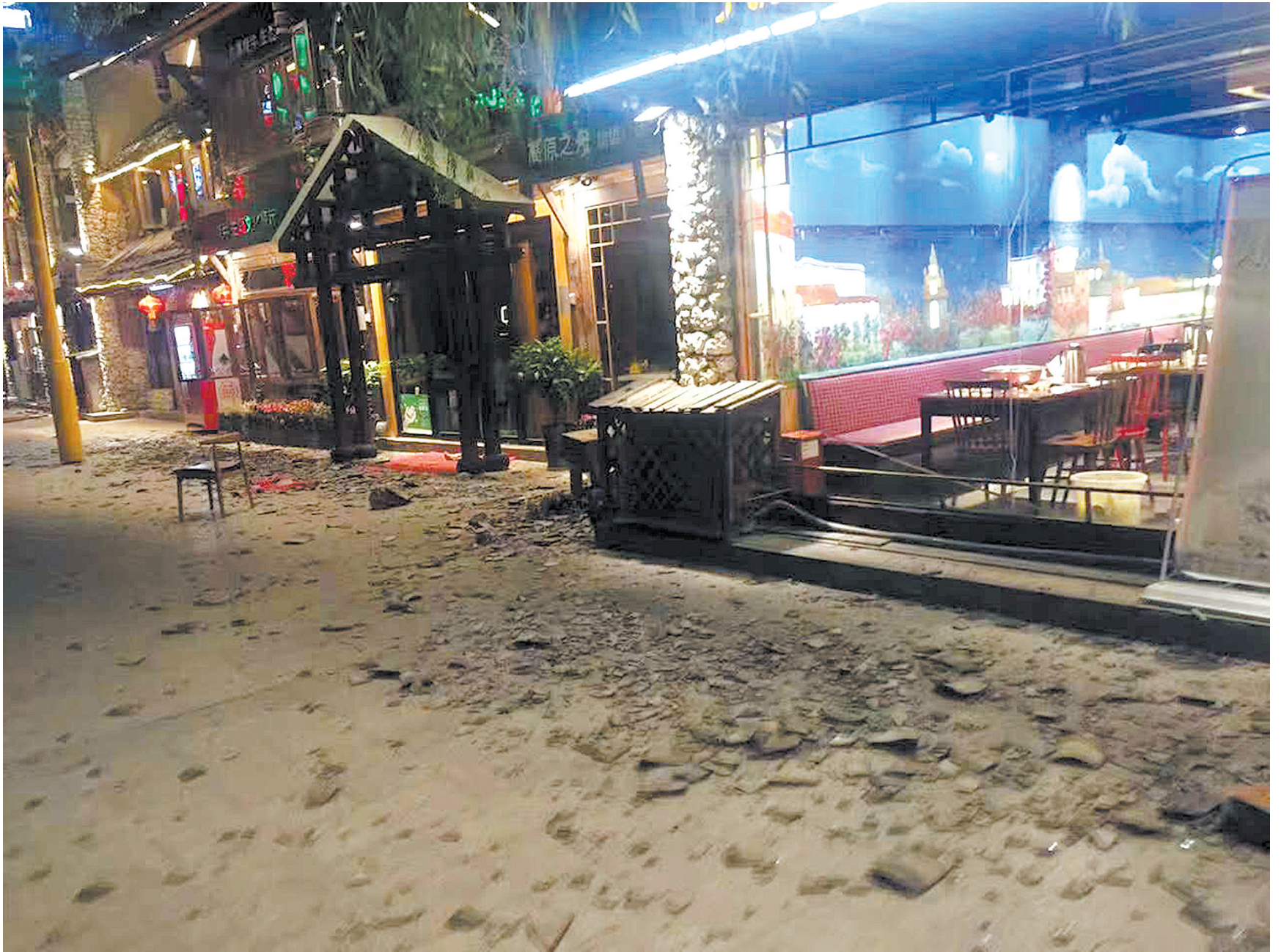
九寨沟景区游客中心附近受损的街区(8月8日摄)。新华社发
