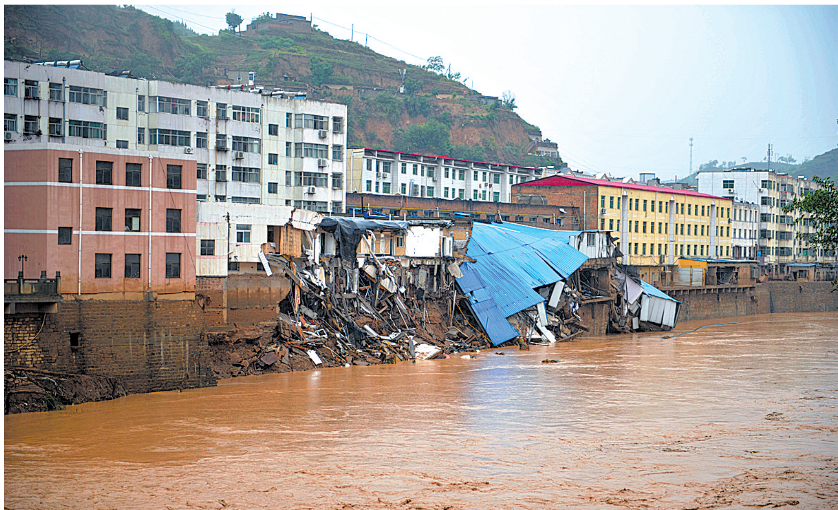
7月27日,绥德县城内一座建筑被洪水冲塌。(本版图片均来自新华社)
