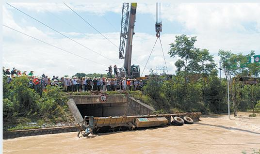
7月3日,位于长沙市望城区的湘江支流沱水河出现溃口,望城区乌山街道南中垸坑内数千亩土地受灾,洪水通过多处涵洞和溃口灌入相邻的团山湖坑,受灾区域蔓延扩大,情况十分危急。当地抗洪抢险部门7月3日上午用起重车把挂车封堵在贯穿团山湖坑的京港澳高速复线的一处涵洞洞口,大大减缓了洪水涌入涵洞的流速和流量。
