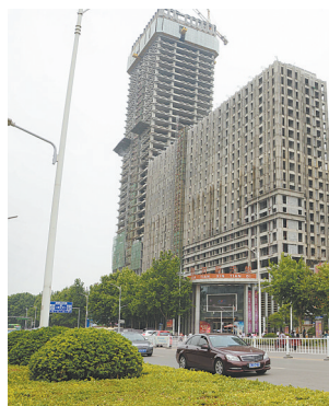
市区建设路一在建楼盘外景。本报记者 张鹏 摄
