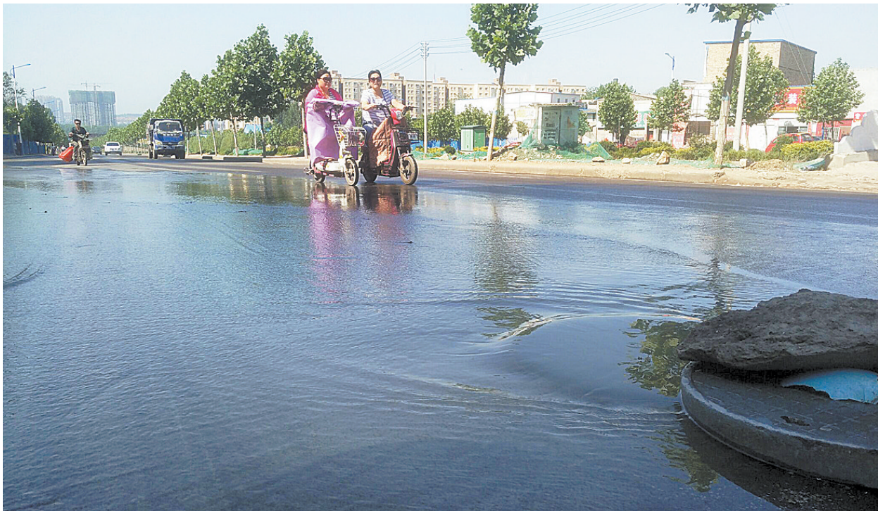
窨井不断向外冒污水,覆盖了大半个路面。本报记者 杨元琪 摄
