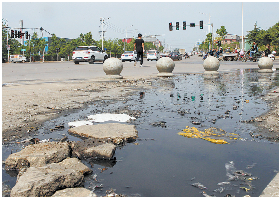
市区光明路与新南环路交叉口的污水带。
