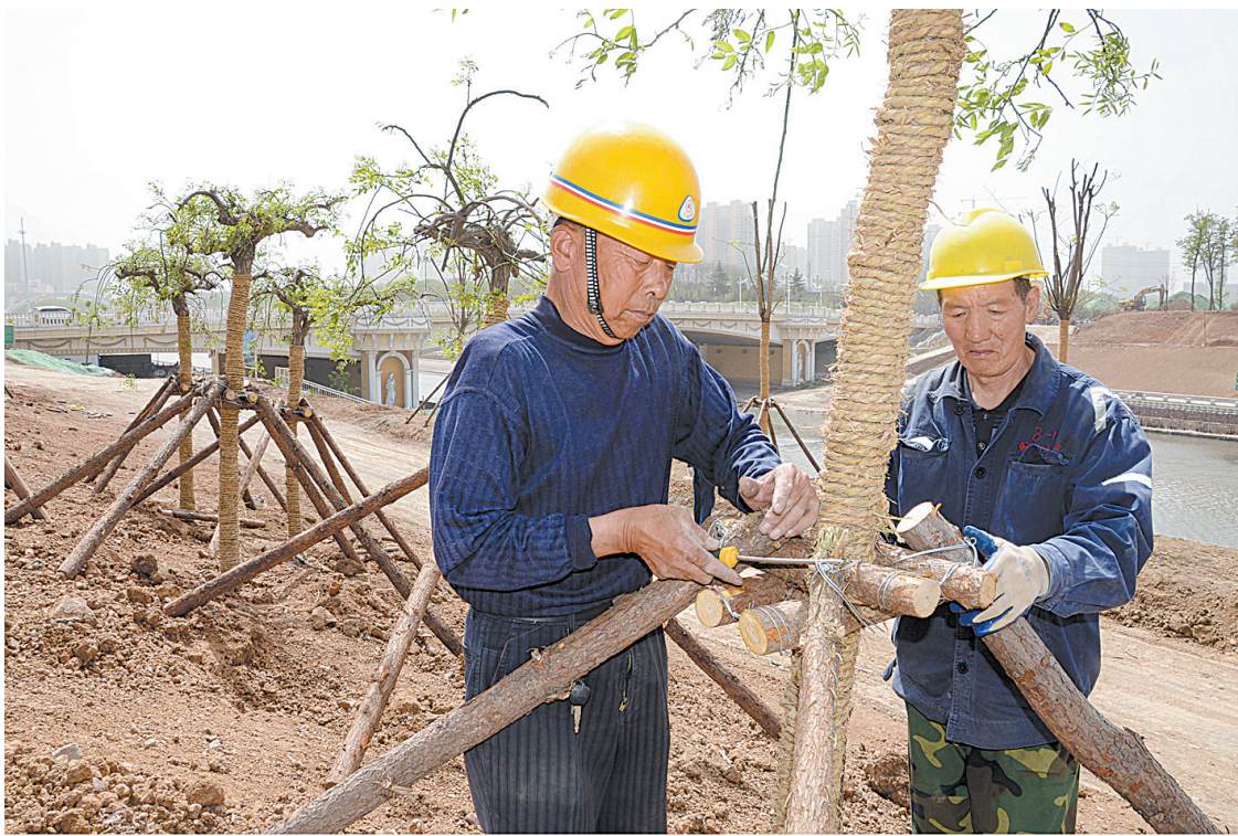
昨天上午,市区凌云路湛河桥西侧河堤上,施工人员为刚栽种的桂花槐打支架。湛河槐树林特色景观带造型初现。 本报记者 张鹏 摄
