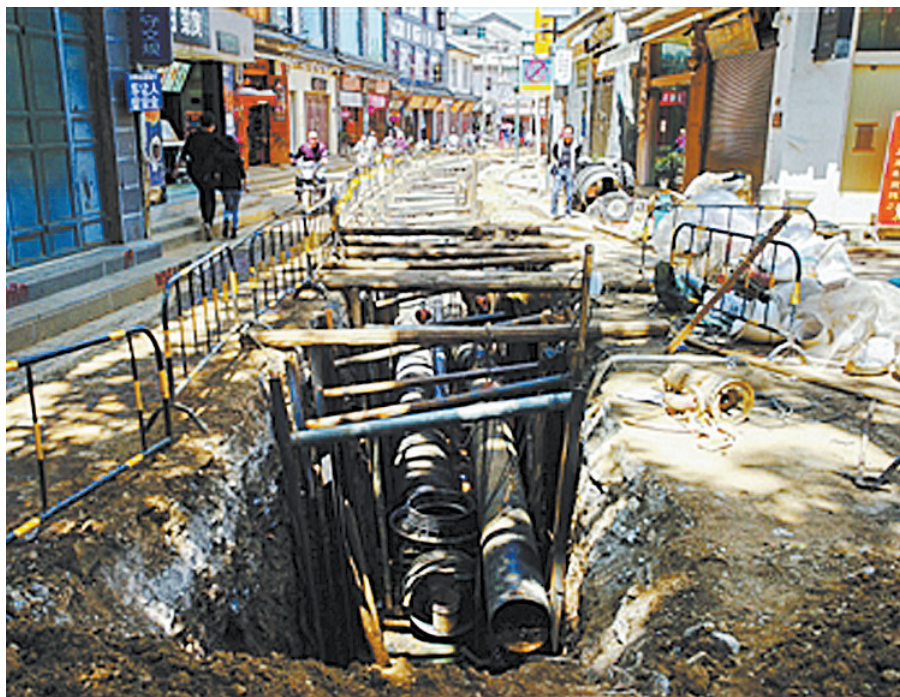
4月10日,在双廊镇,一条道路因施工被挖开。
