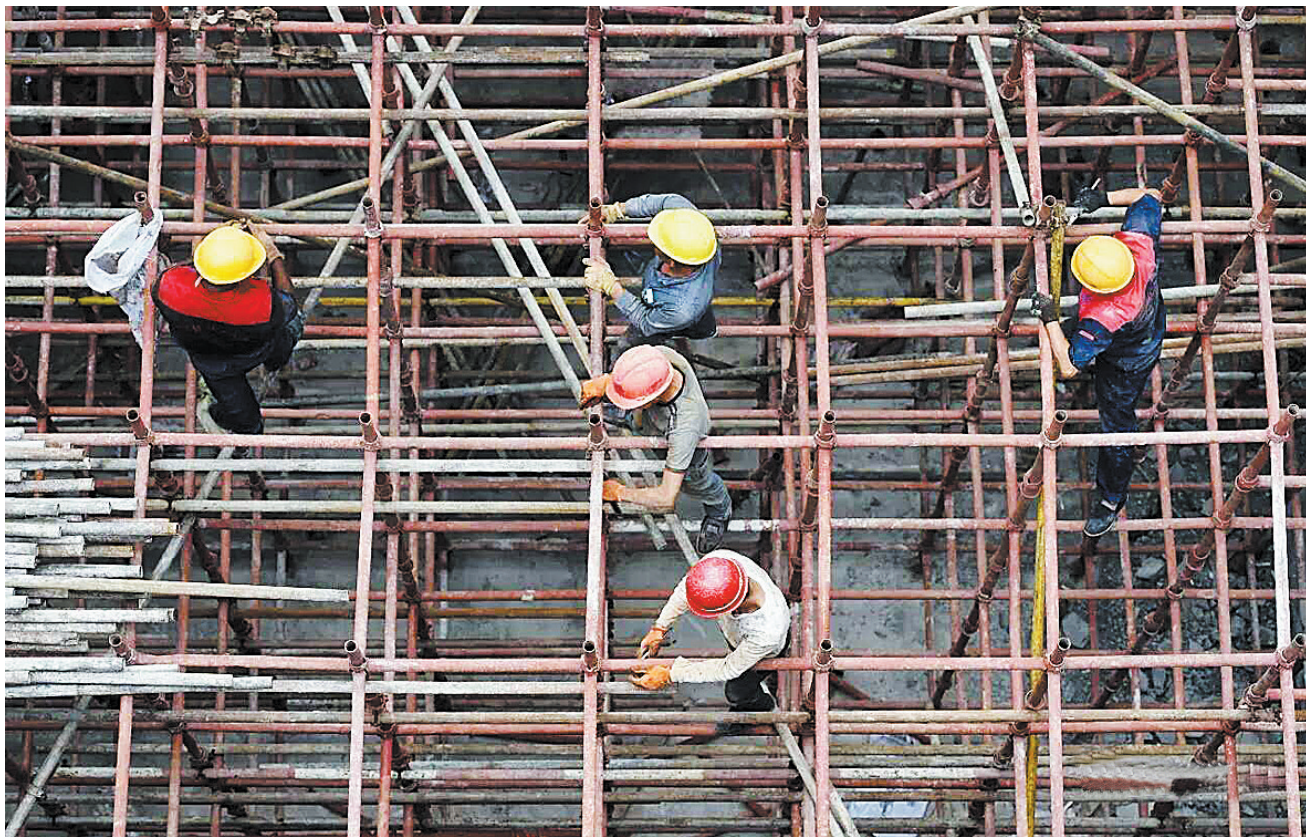
9月15日,中铁十八局集团四公司的几名工人在昆明塘子巷车站安装脚手架。新华社发
