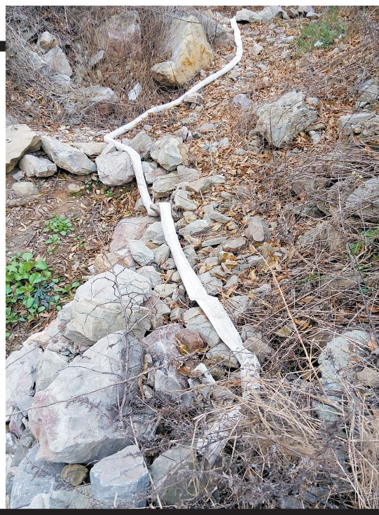
西区楼房的排污通道
