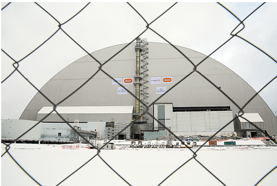
11月29日,切尔诺贝利核电站新掩体正式竣工,将4号机组反应堆罩住。新华社记者 陈俊峰 摄
