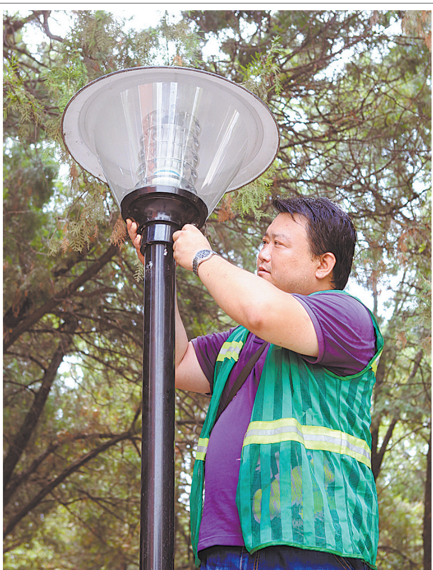
炎炎烈日下 维修景观灯
