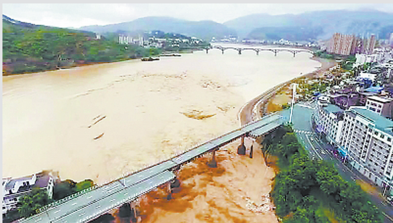
福建溪口大桥被洪水冲塌,部分路段出现塌方。
