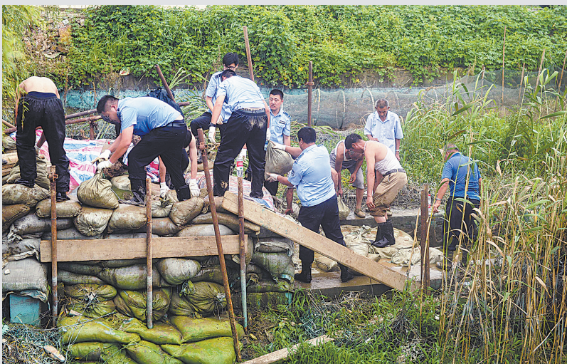
昨天,在宜兴市周铁镇中新村,突击队员对太湖大堤内侧进行加固。当日,为应对未来几天有可能出现的雨情、汛情,江苏宜兴市周铁镇40多名机关青年志愿者等组成的突击队继续加强巡查查险,对太湖大堤薄弱处进行加固。
