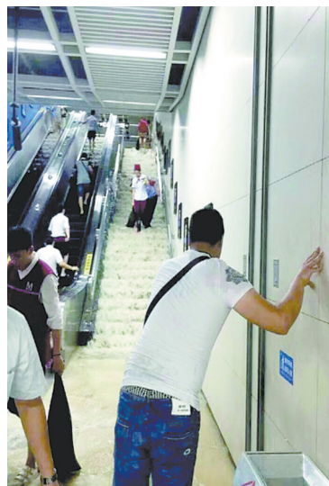
武汉地铁2号线、4号线多个出入口突然进水,部分站点采取临时封闭措施。
