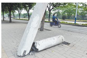
线杆折断没人管
